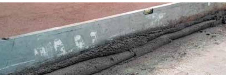
Nach der Fertigstellung muss DICHTsystem SUPERSCREED vor eindringendem Wasser geschützt werden. Dafür die poröse Oberfläche mit 1K-PUR Primer grundieren und mit DICHTsystem Abdichtungsprodukten abdichten. Bei höherer Belastung, z. B. befahrbar, erhöht sich die Menge des Bindemittels.
